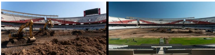
Imagen 4: Obras de remoción del campo de juego realizadas en el año 2020.
